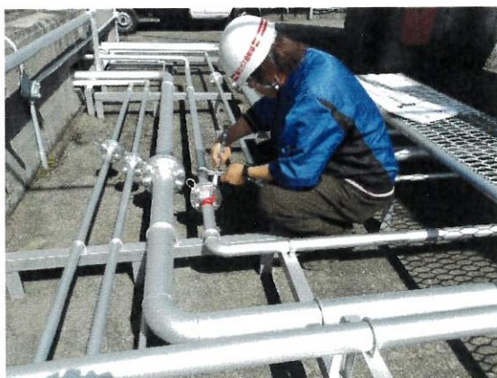
漏洩部応急措置
